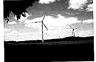
Parc éolien de Puschwitz (Saxe, Allemagne). Dix éoliennes sont érigées dans un paysage collinaire présentant des habitats très variés, y compris de nombreux cours d'eau. Entre 2002 et 2006, 76 cadavres de chauves-souris ont été trouvés sous les éoliennes, principalement des Noctules communes ( Nyctalus noctula ), Pipistrelles de Nathusius ( Pipistrellus nathusii ), Pipistrelles communes ( Pipistrellus pipistrellus ) et Vespertillons bicolores ( Vespertilio murinus ). © M. Lein
